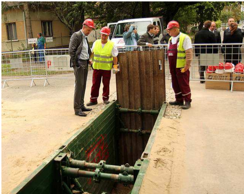
A csatornagödör közelről: hamarosan helyére kerül a kétéves beruházás első csatornacsöve a Szemere István téren. Riz Levente az építőmunkásokkal beszélget a gödör szélénél.
