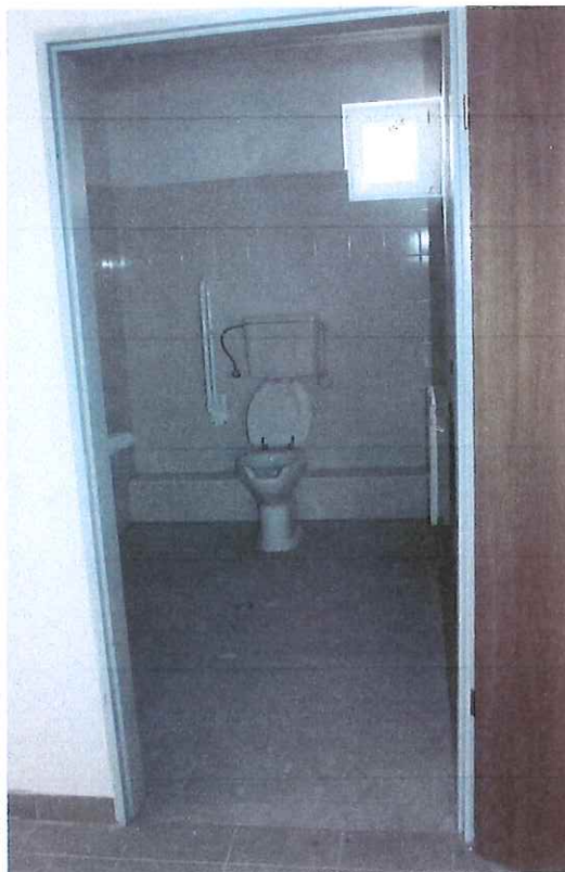
Mozgáskorlátozottak emeleti WC-je
